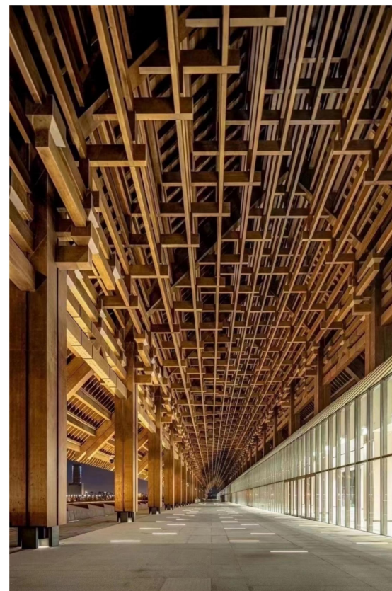
亚洲最大单体木结构建筑 四川省重点工程 中国优秀文旅木结构工程大型场馆类一等奖
